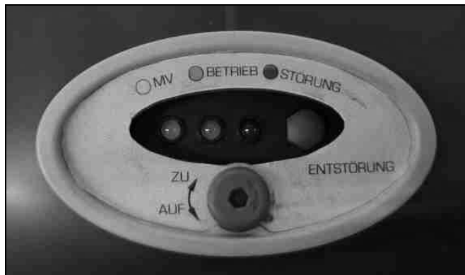
Рис. 1: индикаторная панель Logatop GE1H жёлтая лампа ⬇️ Электромагнитный клапан; зелёная лампа ⬇️ Прибор в работе; красная лампа ⬇️ Сбой; / Разблокировка
